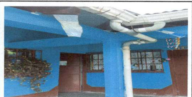
Foto 6: Reparación de bajada de agua.
