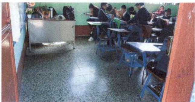
Foto 3: Sustrucción de Piso de Granito
