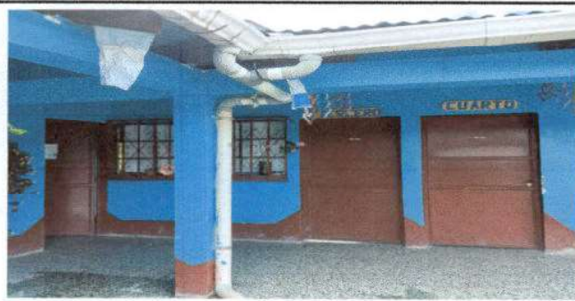
Foto 5: Reparación de bajada de agua.
