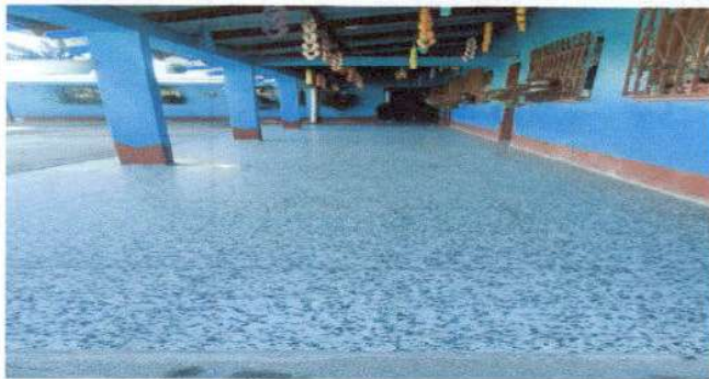
Foto 1: Sustrucción de Piso de Granito.
