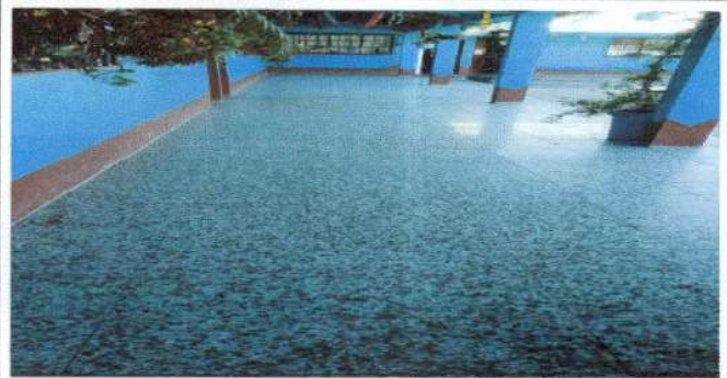
Foto 2: Sustrucción de Piso de Granito.
